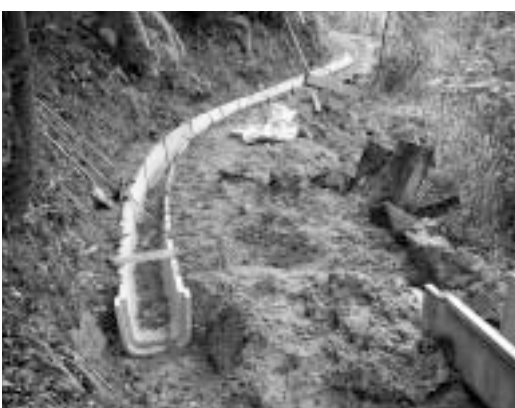
今年度から改良事業が再開された桐迫農業用水路
