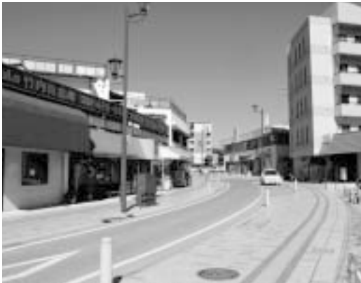
整備が進む中央通り
