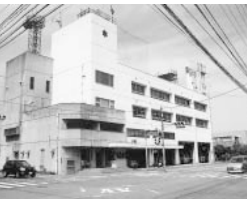
老朽化する消防庁舎
