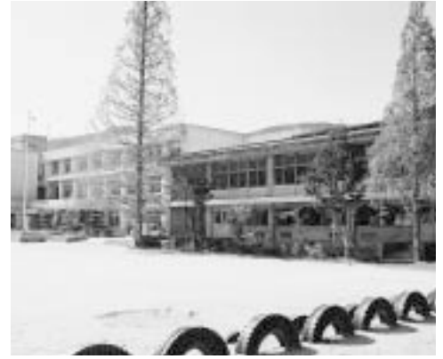
改築予定の風早小学校屋内運動場（安芸津町）
