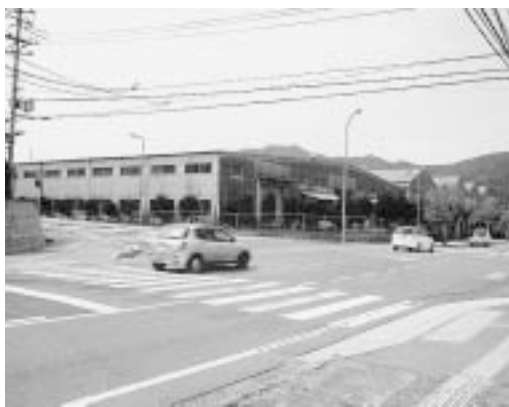
市道飯田線と県道東広島向原線の交差点
