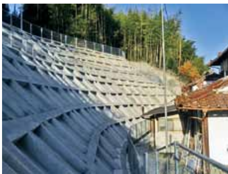
急傾斜地崩壊対策事業
