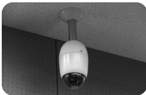
○議場カメラ：議場に設置された3台のカメラ。前、横、後に設置
