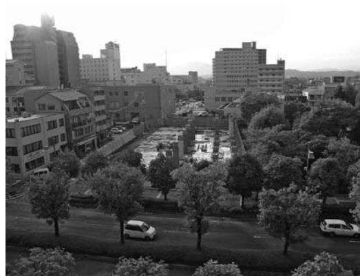
工事が中断した仮称「東広島ホテル」建設予定地
