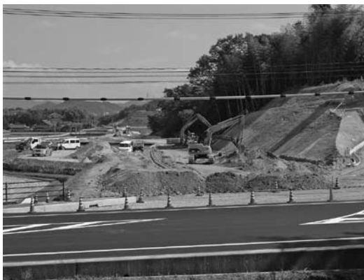
道路の建設工事現場
