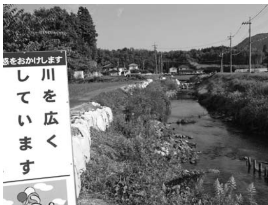
入野川の改修工事現場 (西高屋駅前近)
