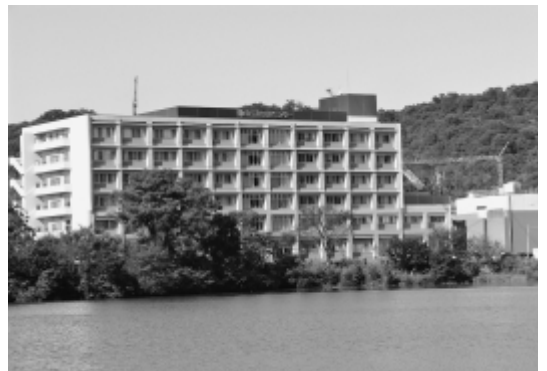
地域周産期母子医療センターの入る東広島医療センター
