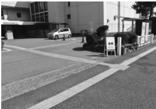
施設敷地内と連結している点字ブロック
