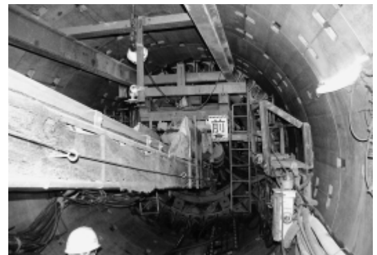
地中を掘り進む掘削機械
