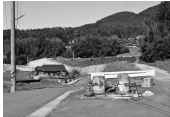
建設途中の東広島向原線
