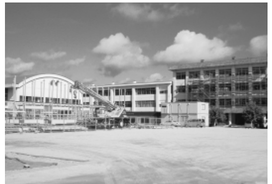
耐震化工事中の高屋西小学校
