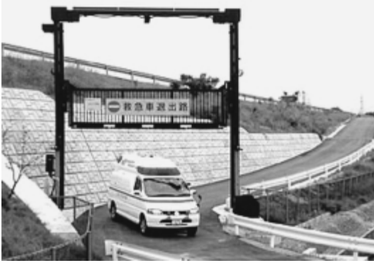
山形自動車道の救急車緊急退出路(国土交通省のHPより)
