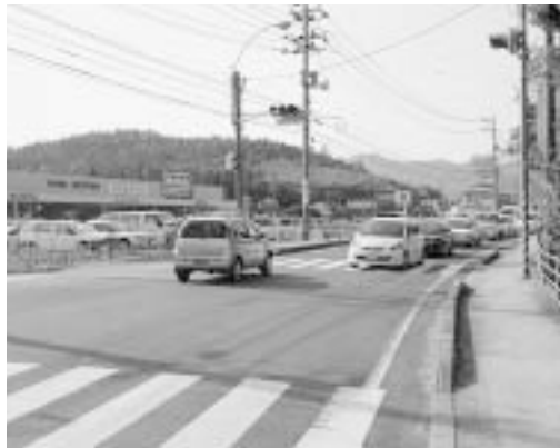
右折レーンがないため滞る国道486号線
