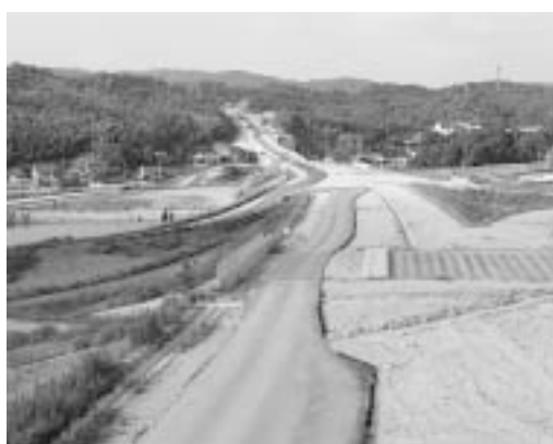
整備が進められている東広島呉自動車道
