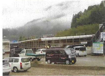
建設中の高専
