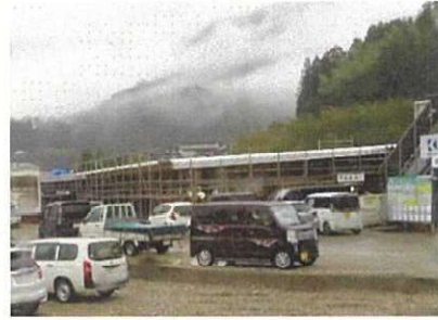
建設中の高専
