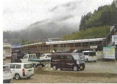
建設中の高専
