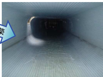
府中1号幹線(施工後)
