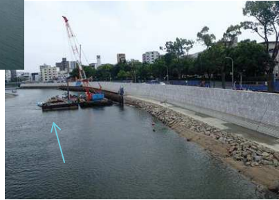
天満川右岸施工状況(広瀬橋下流)
