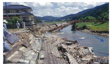
▲橋梁の被災状況
