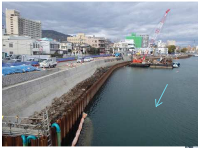
天満川右岸施工状況(広瀬橋上流)
