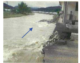
▲家屋の被災状況
