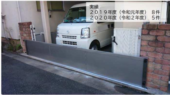
【止水板の設置例】
