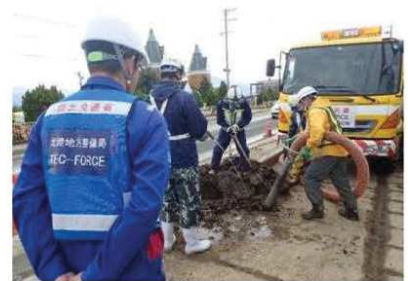
10月24日 長野県長野市における路面清掃作業【北陸地整・応急対策班】
