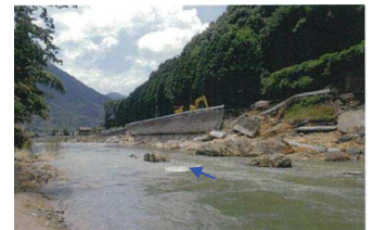
▲護岸の被災状況
