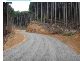
【森林整備：林道（整備）】
