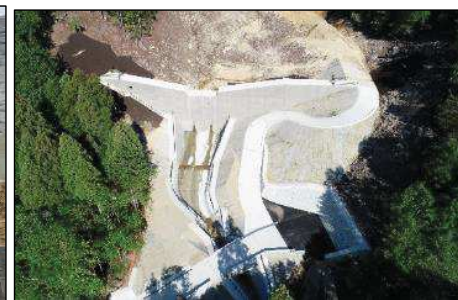
城北4号砂防堰堤(広島市安佐北区)
