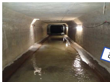
府中1号幹線(施工前)
