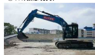
③遠隔操縦(無人化)施工
