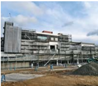
建設中の広島中央エコパーク
