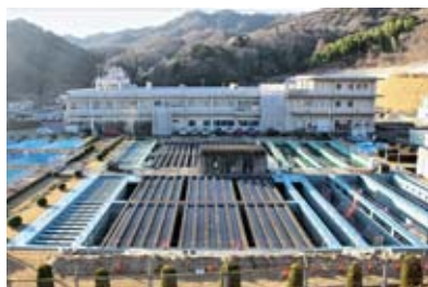
広島県の瀬野川浄水場
