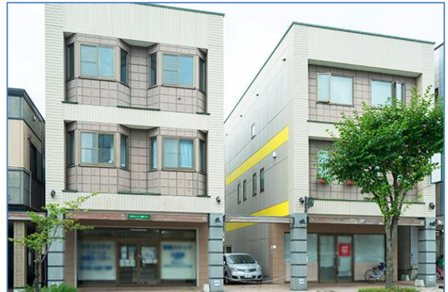
移住お試しハウス外観(弘前市提供資料)
