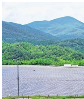
太陽光発電設備
