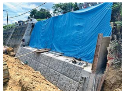
復旧工事の様子
