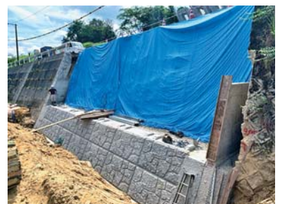
復旧工事の様子
