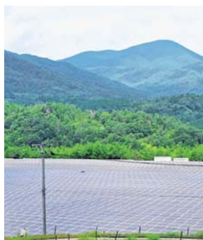
太陽光発電設備
