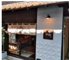
西条駅前の古民家を改修したチョコレート店
