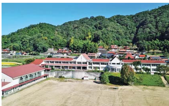
旧河内西小学校校舎
