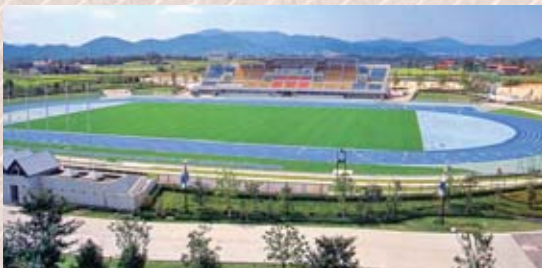
東広島運動公園陸上競技場 (改修前)
