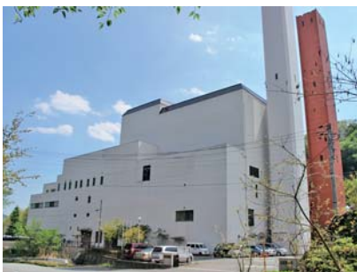
現在、ごみ処理を行っている 賀茂環境衛生センター
