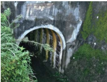
昭和隧道入口
