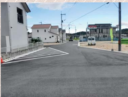
市道認定された市道上組23号線（八本松町）
