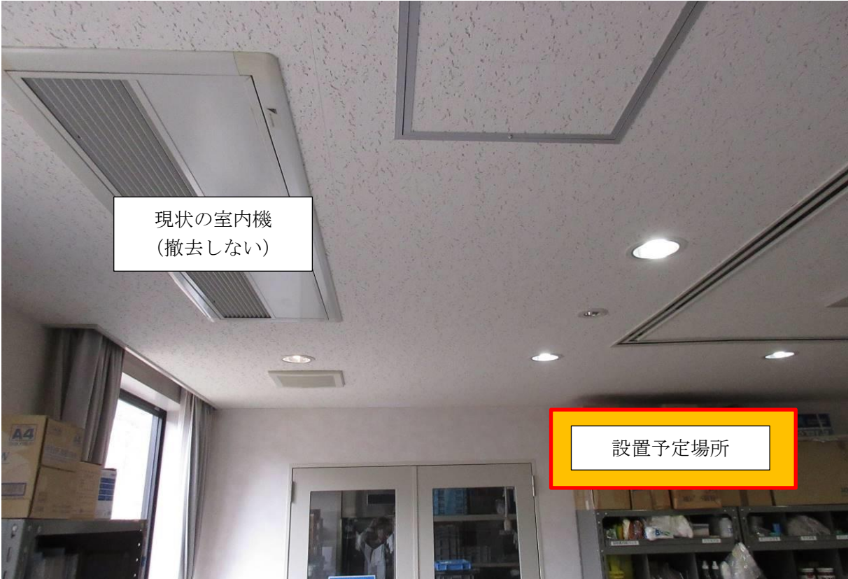
室内機の設置予定場所 (この裏側の部屋に排水可能な流し有り)
