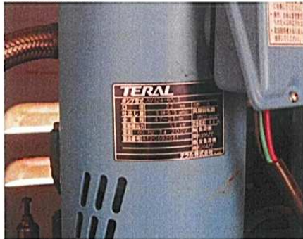
テラル加圧ポンプ
