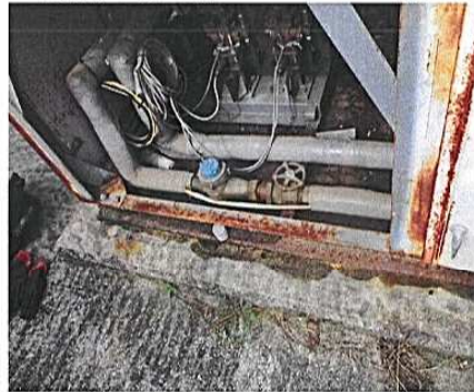
テラル加圧ポンプ
