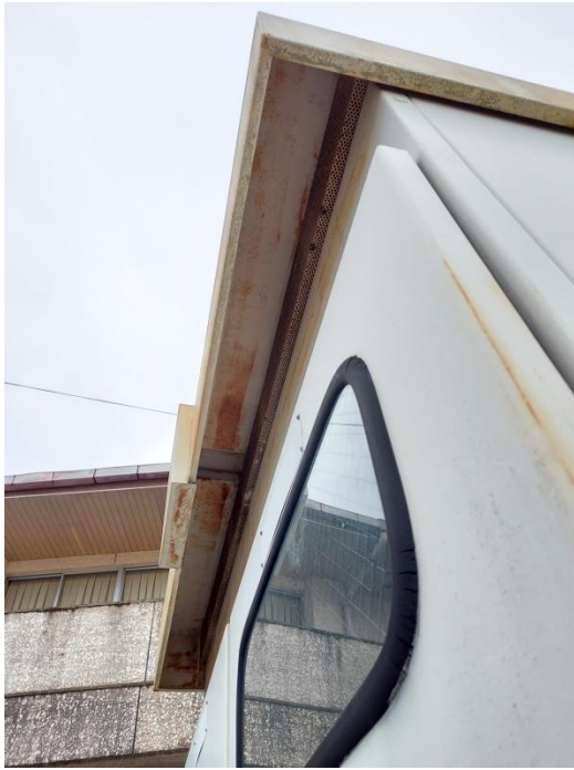
【正面天井内側】
