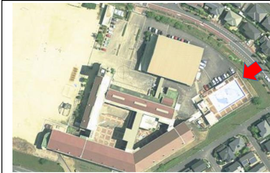
【設置場所】 プール北側の空地
