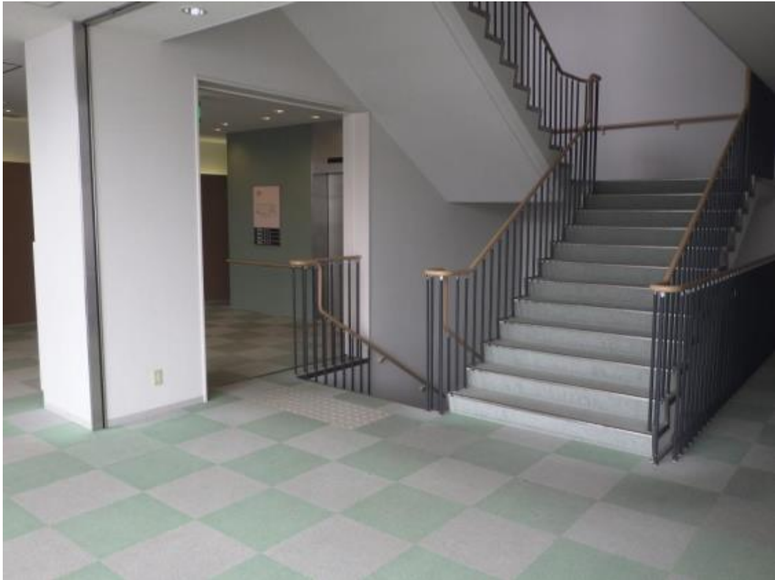
別紙3 現況写真（安芸津支所3階フロア）
