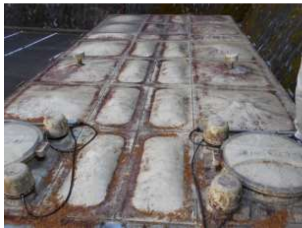
図2：対象設備（天板目地）
