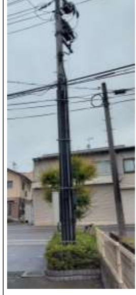
建物裏手（電柱）
