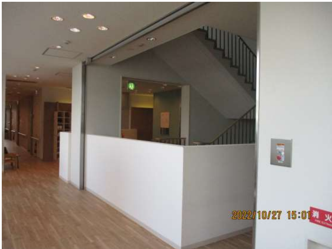
別紙3 現況写真（安芸津支所3階フロア）
