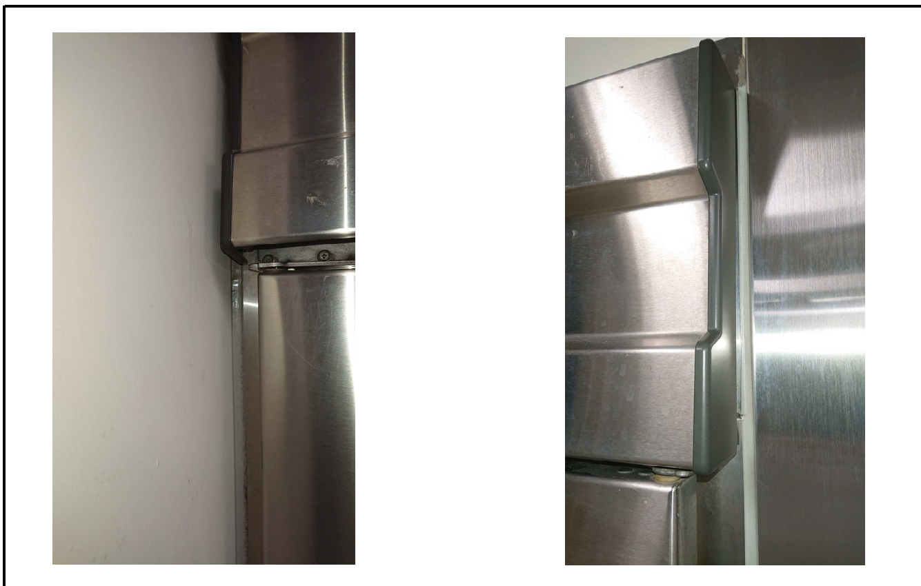
パススルー冷蔵庫 調理室側 壁(充填剤塗布箇所)
