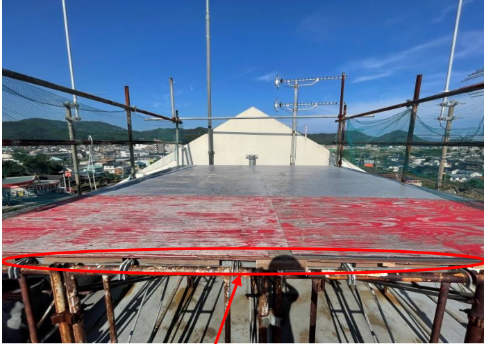
先端部分は垂木で補強
