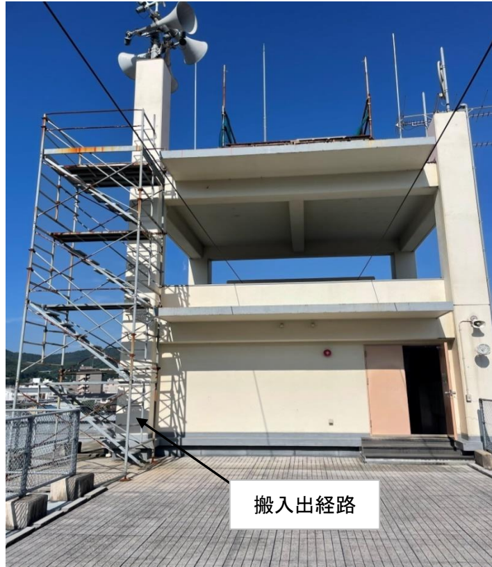
竹原消防署屋上訓練塔 東側
