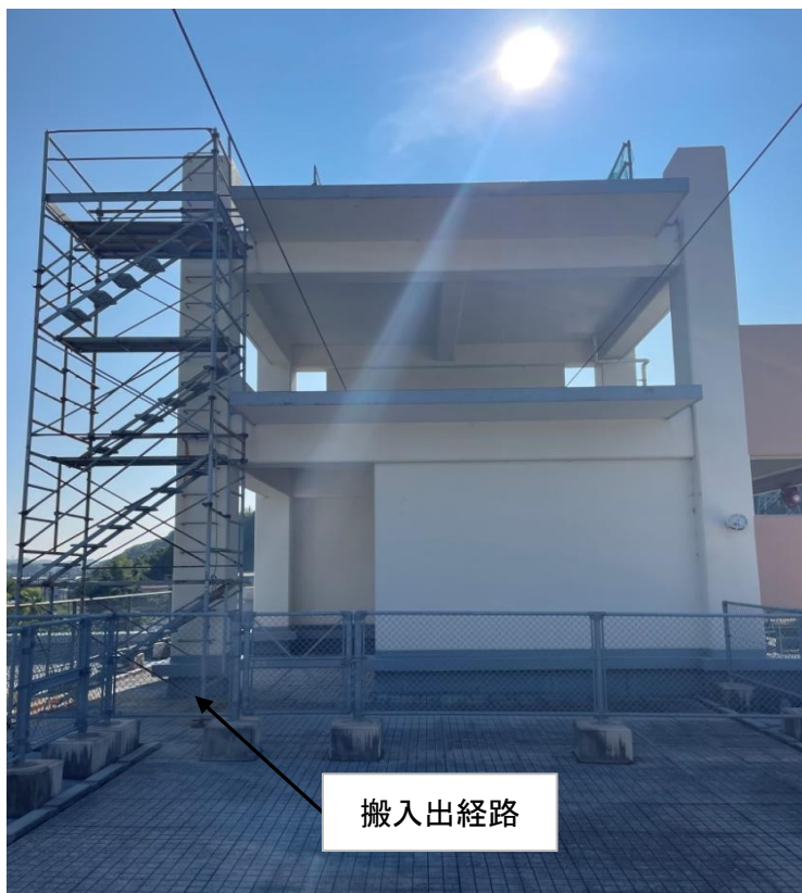
竹原消防署屋上訓練塔 西側
