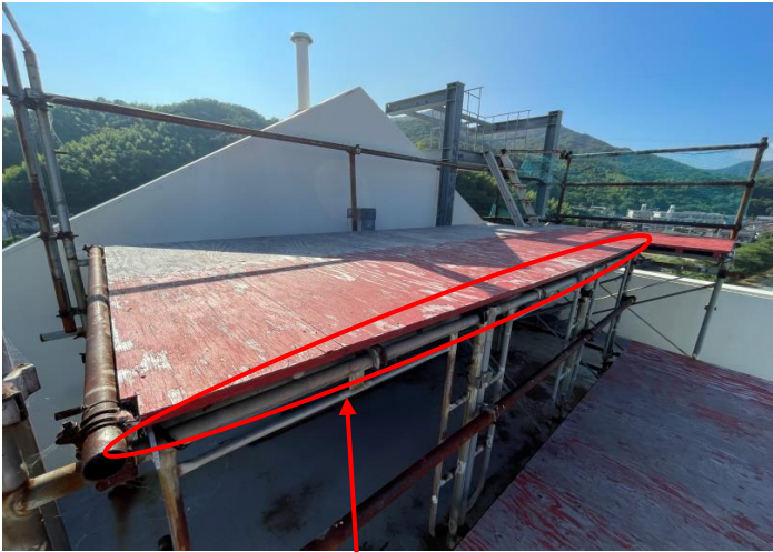
先端部分は垂木で補強
