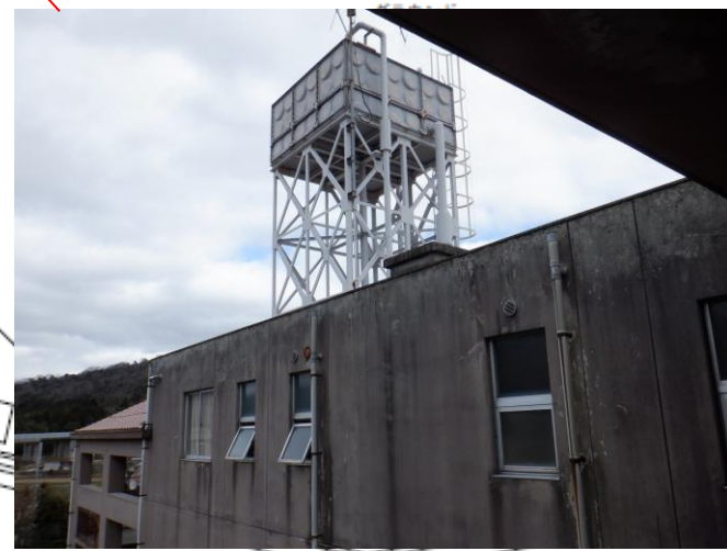
既設高架水槽 (校舎棟屋上)
