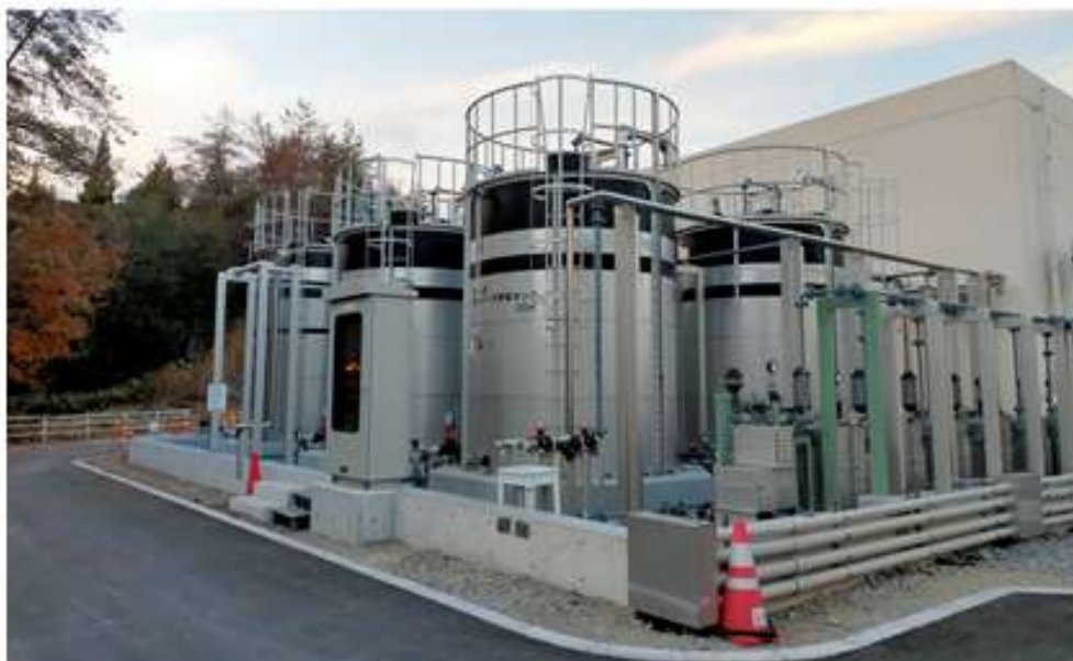
場所: 水処理棟西側
