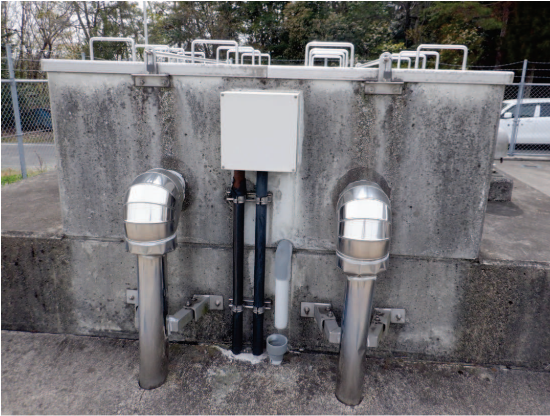
対象設備 配水池外観（2基）
