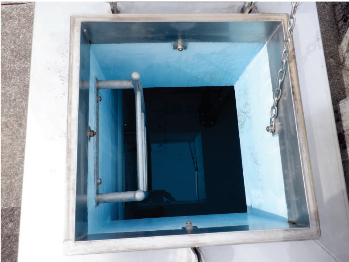
配水池内状況
