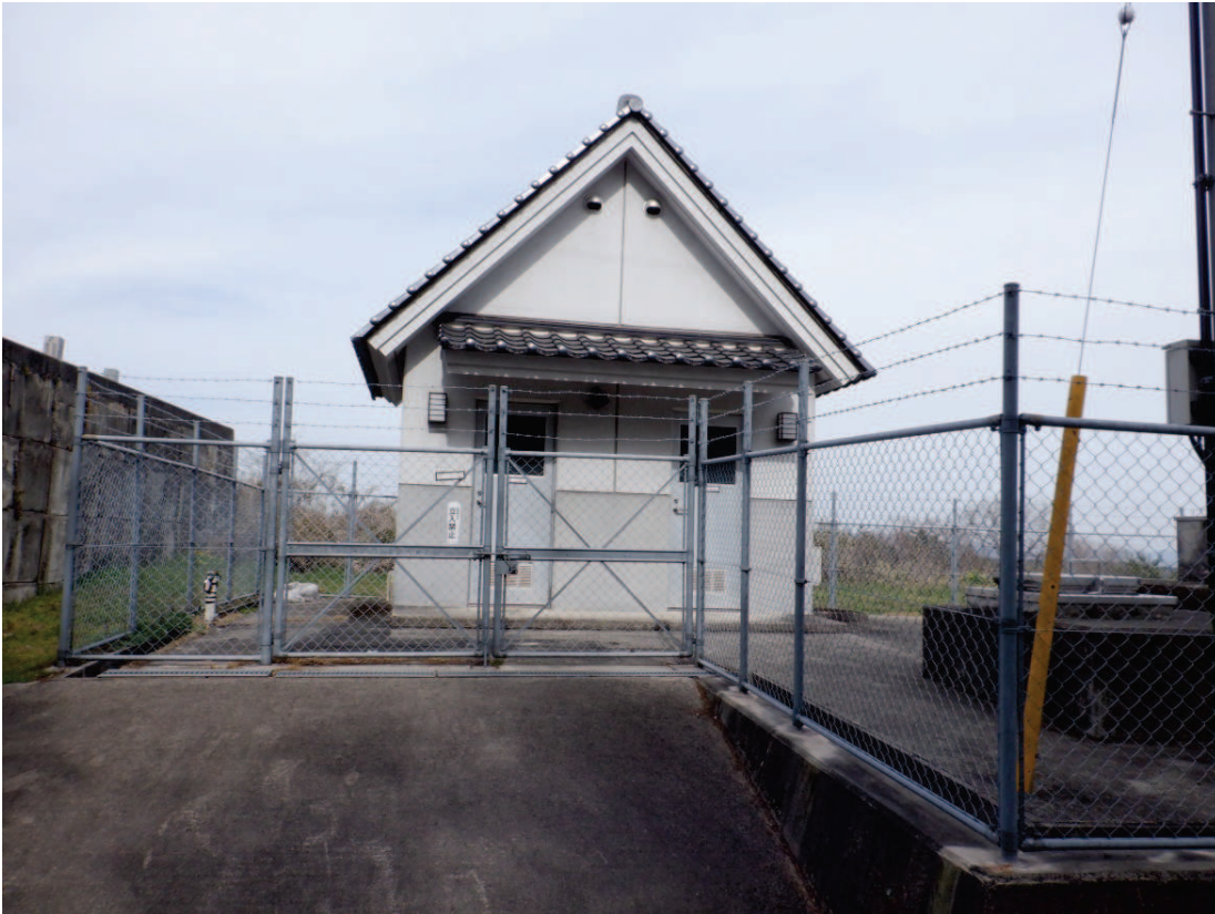
飲料水供給施設 外観
