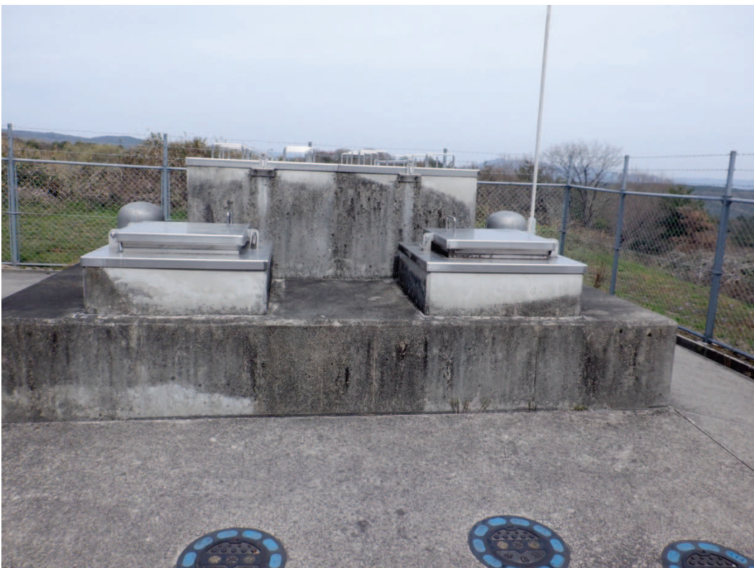
対象設備 配水池外観（2基）
