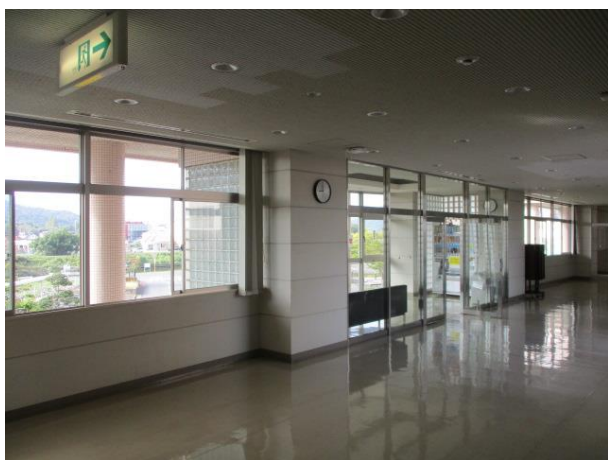
⑫2 階廊下（撤去のみ）
