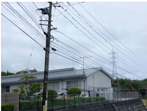
道路向かい側から
