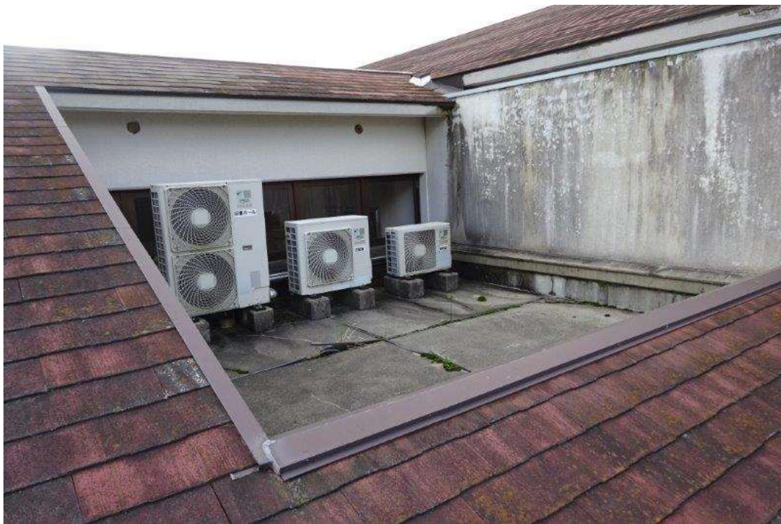
図書室上部陸屋根
