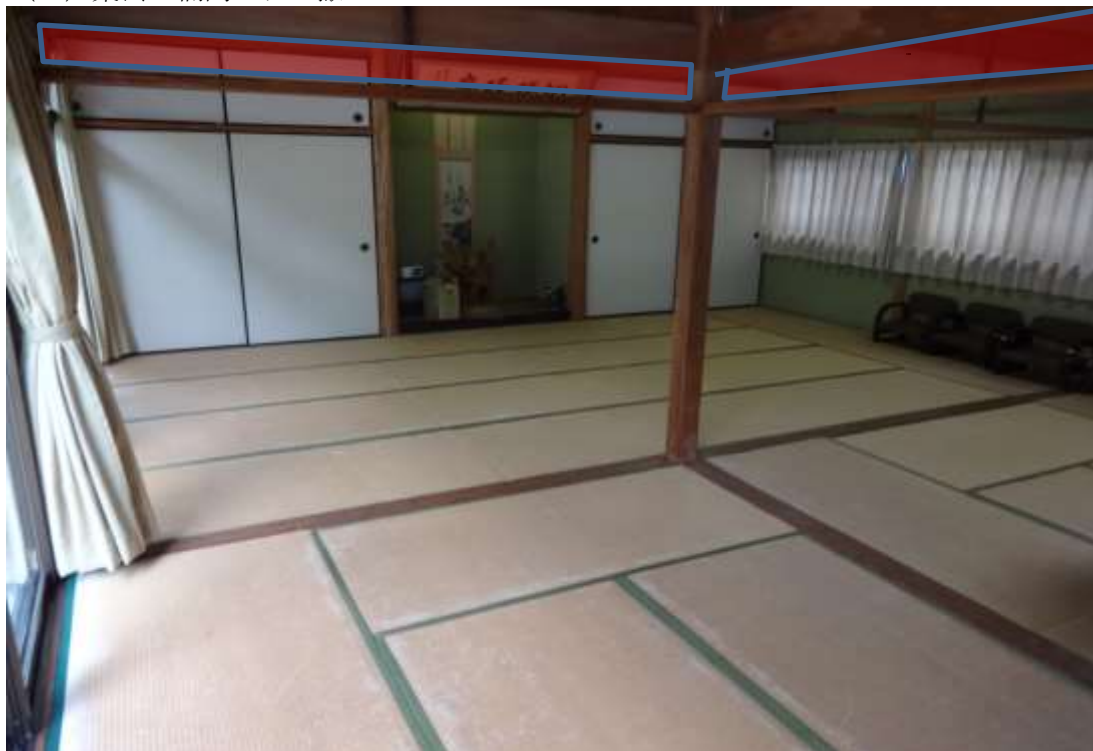
(5) 集会室欄間ガラス撤去
