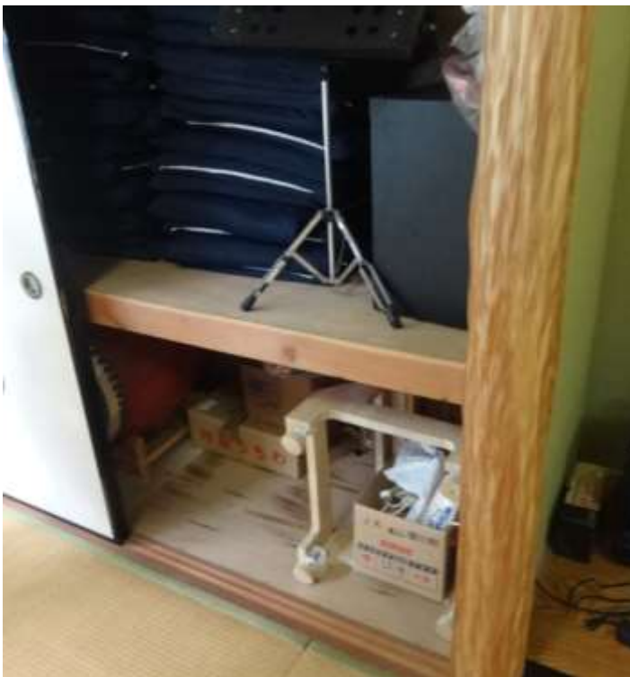
(4) 押入れ部床張替
