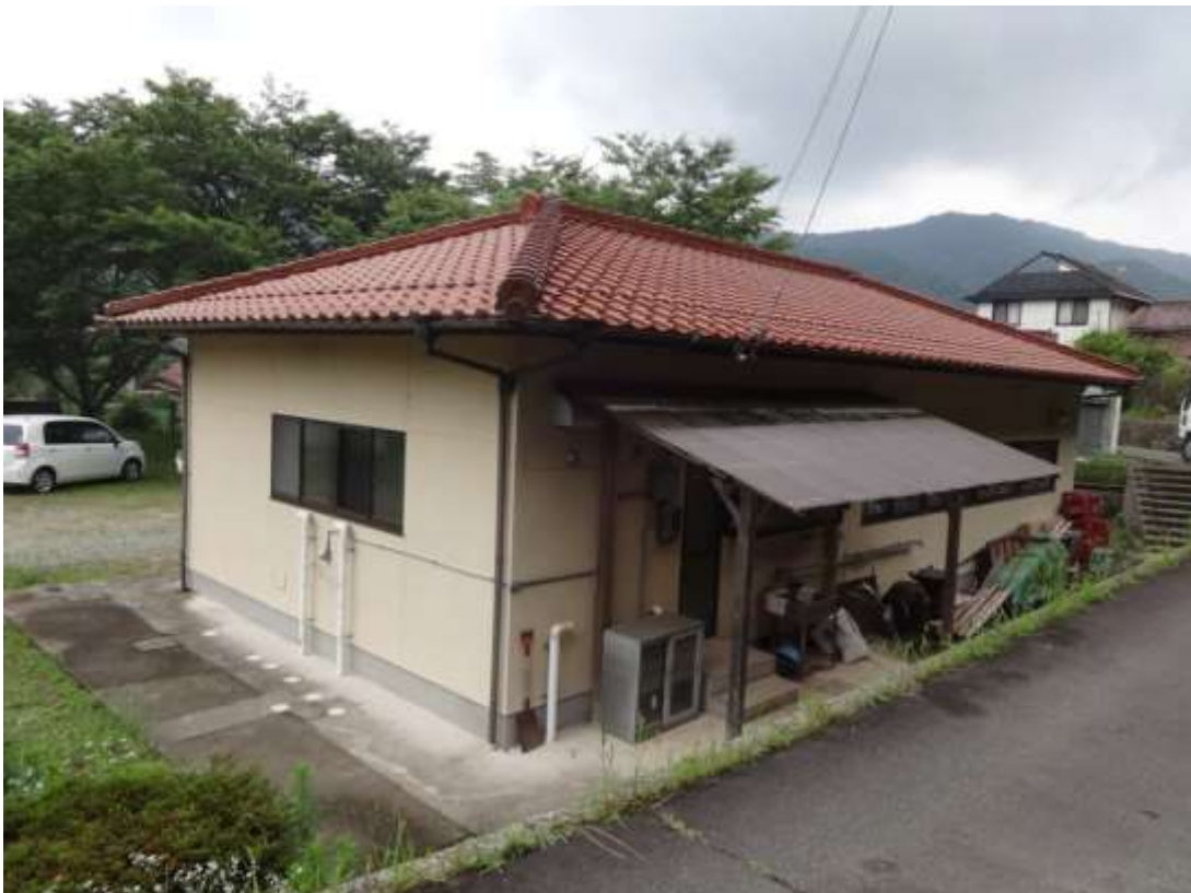
(3) 本棟及び隣棟部の瓦巻き替え
