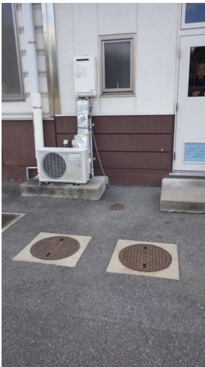
庁舎1階の男子便所の建物外部と汚水マス
