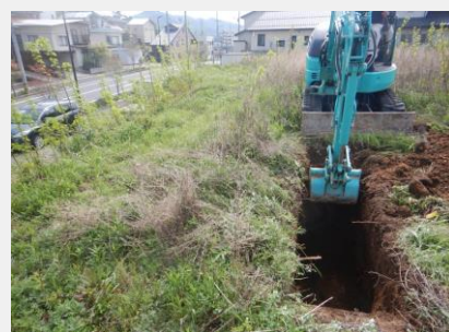
写真 2-6 試掘調査の様子
