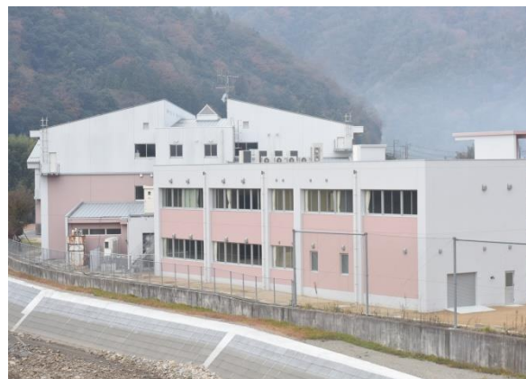
河内小中学校の完成写真
