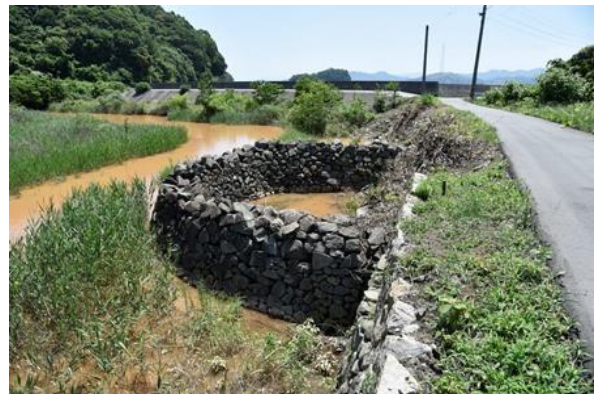
↑海水の取水口を波から守るための 「丸樋(まるひ)」(安芸津町二馬手)
