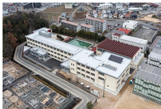
東西条小学校長寿命化改良完成写真 (南東面) ※児童数増加に対応した増床 ※太陽光発電の設置
