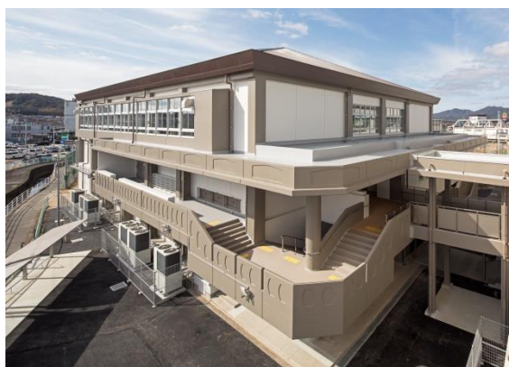
西条中学校長寿命化改良完成写真 (屋内運動場) ※校舎と屋内運動場を渡り廊下で 接続（バリアフリー化） ※空調設置
