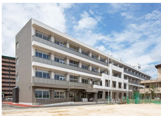
西条中学校長寿命化改良完成写真 (校舎) ※断熱化や照明のセンサー点灯及び LED化による省エネ化
