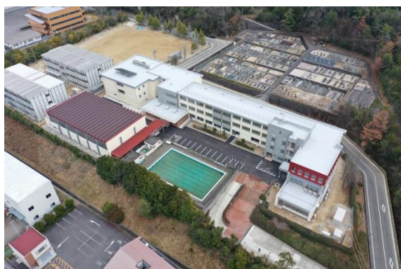
東西条小学校長寿命化改良完成写真 (北西面) ※職員室の増床
