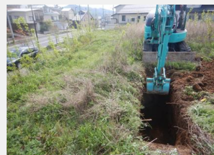
写真 2-3 試掘調査の様子
