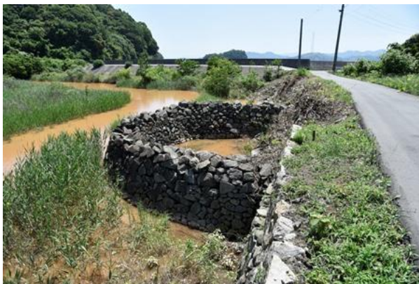
↑海水の取水口を波から守るための 「丸樋（まるひ）」(安芸津町二馬手)
