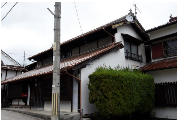
保手濱家住宅主屋(南西から)
