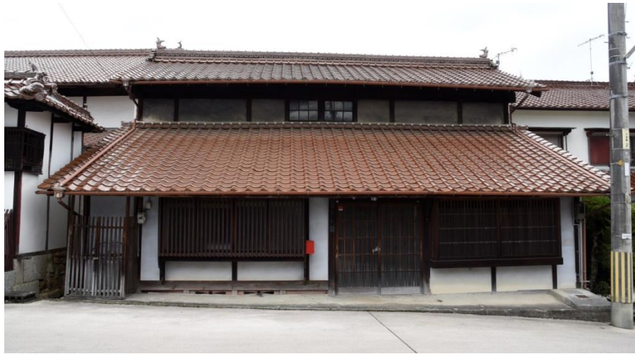
保手濱家住宅主屋(西から)
