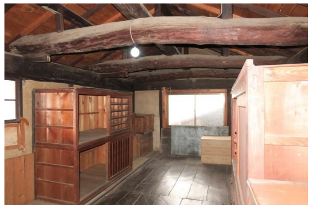
保手濱家住宅主屋2階(南から)
