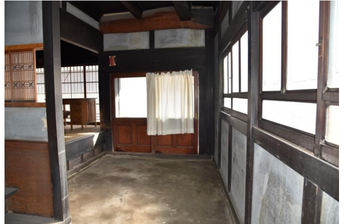
大藤家住宅(通り土間から玄関を見る)
