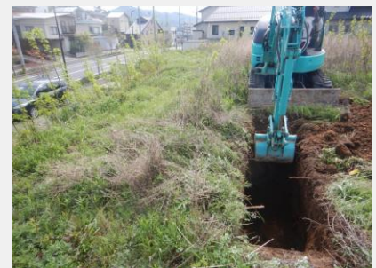
写真 2-3 試掘調査の様子
