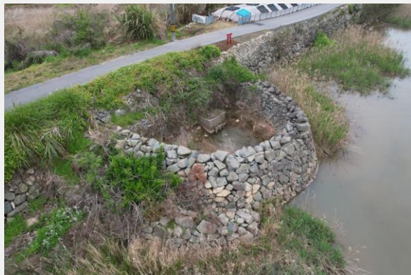
写真 1-25 市史跡 二馬手塩田跡 樋の輪
