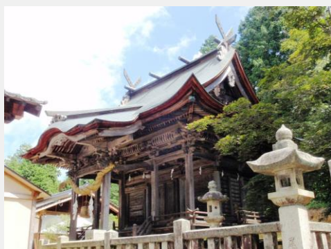
写真 2-10 市重要文化財 新宮神社本殿
