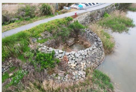
写真 2-14 市史跡 二馬手塩田跡 樋の輪
