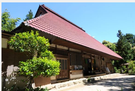
写真 2-4 並瀧寺庫裏（市重要文化財）
