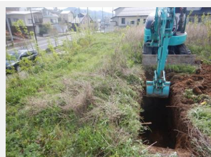
写真 2-6 試掘調査の様子
